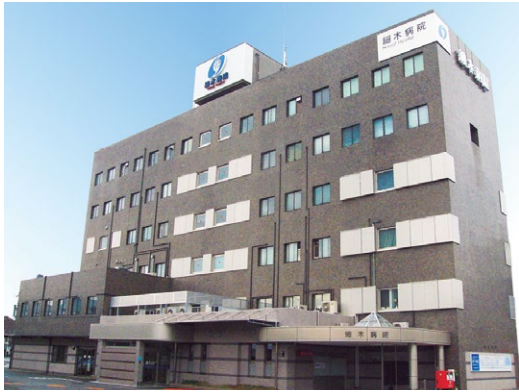
細木病院 本館
